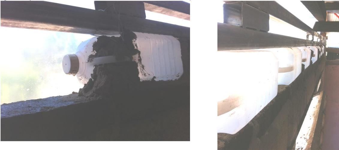
Figura 7. Resultado del proceso de relleno con embases PET. Vista interior dintel del dormitorio
