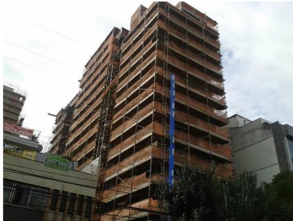
Figura 1: fachadeiro utilizado na Obra 1
