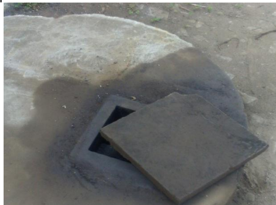
Figura 5. Tanque subterrâneo de armazenamento de óleo lubrificante usado
