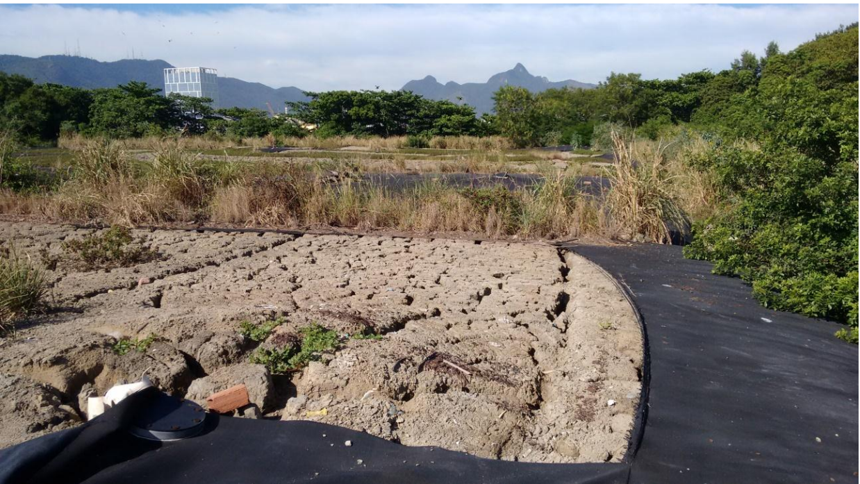
Figura 6 – Região centro-oeste da ilha: Geotêxteis rasgados, sedimento exposto
