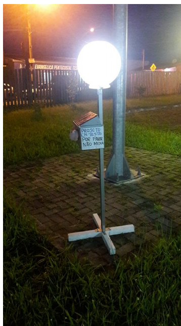
Figura 08: Poste funcionando no período noturno.
