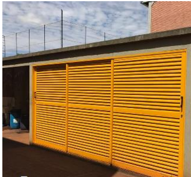
Figura 2 – Depósito para acondicionamento de resíduos recicláveis – Câmpus Campo Mourão - UTFPR
