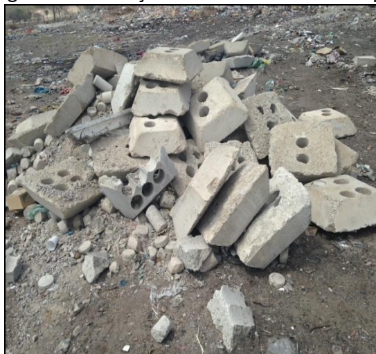
Figura 3: Presença de RCC no lixão de Inhapi.
