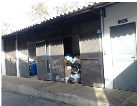
Figura 6. Armazenamento temporário externo para deposição dos resíduos de serviços de saúde da unidade hospitalar.
