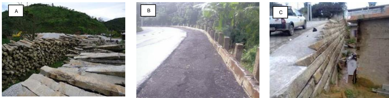
Figura 4 – Dormentes de concreto (A) e utilização na melhoria de infraestrutura de estradas (B e C)
