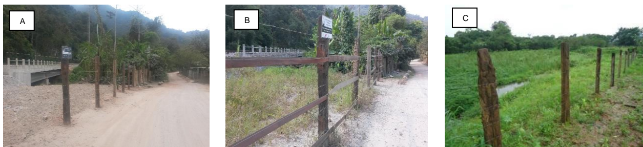
Figura 3 – Utilização de dormentes para delimitação de APPs (A e B) e áreas degradadas (C)
