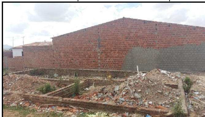
Figura 2. RCDs sendo reutilizado por moradores delmirenses para o aterro em obras.
