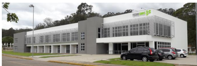
Figura 2: Foto da edificação estudada das fachadas norte e oeste (fonte: Registro dos autores).
