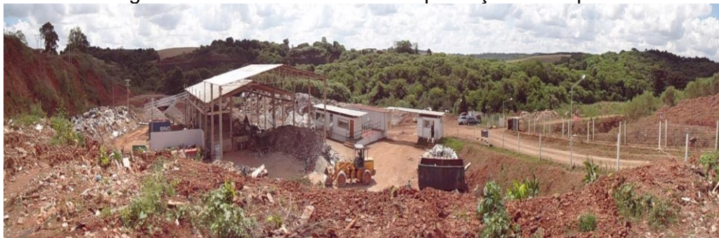
Figura 2: Vista área do local de implantação da empresa
