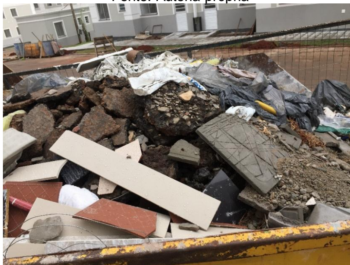
Figura 2: Mistura de resíduos observada na caçamba do CTR nº 42 Fonte: Autoria própria
